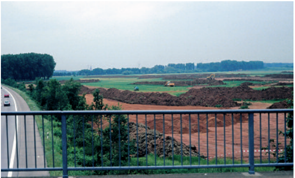
Erdarbeiten auf dem Golfplatz Gymnich.
