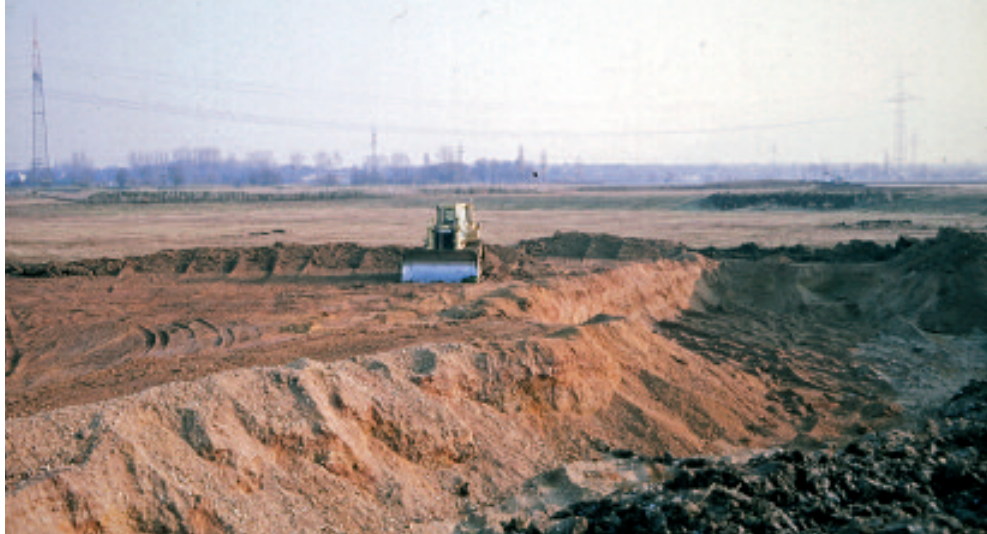
Rückbau des nie fertiggestellten Golfplatzes Gymnich.
