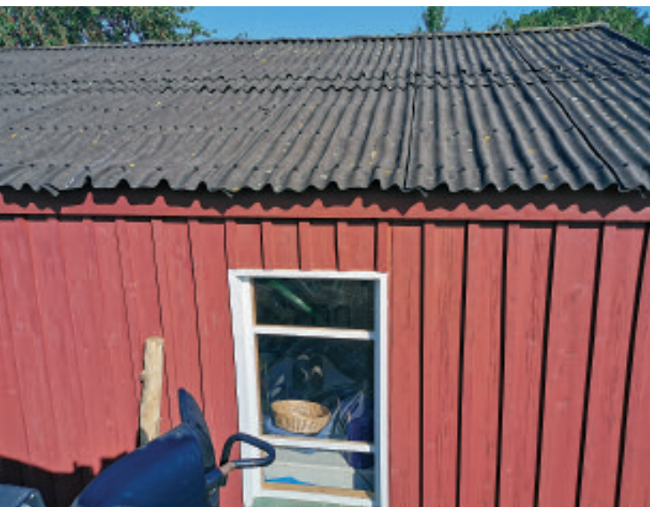
Neue Fenster in der Heuhütte 2020.
