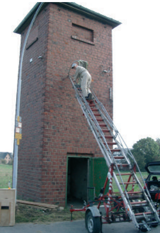
Arbeiten am „Eulenturm“ in Berrendorf.
