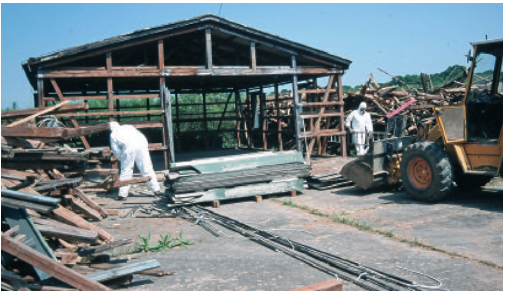
Entfernen der Asbestplatten an der heutigen Heuhütte durch NABU-Mitglieder.
